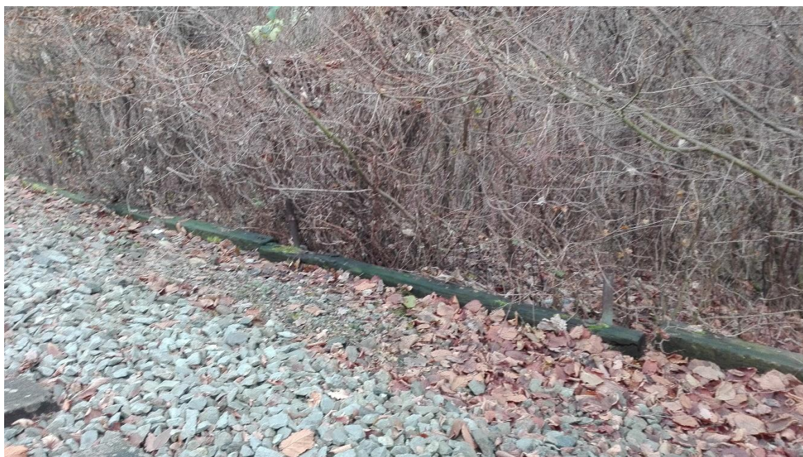
opravy z pražců nad propustkem v km 22,355
